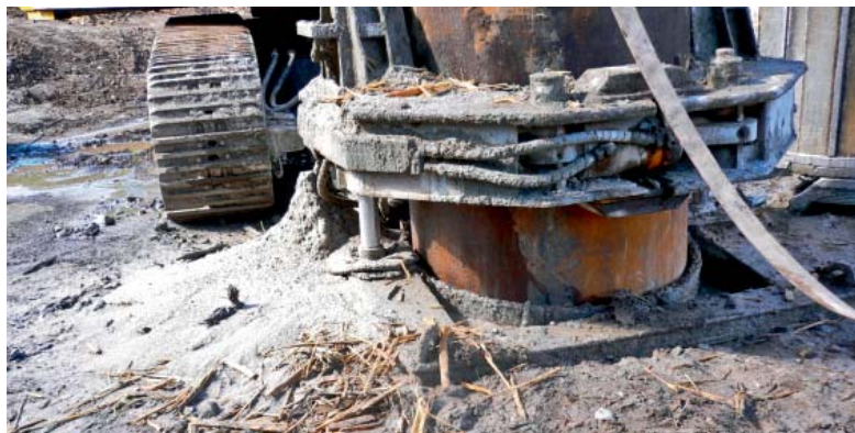
Fot. 11. | Wydobyte na powierzchnię kawałki rozwierconych pali drewnianych
