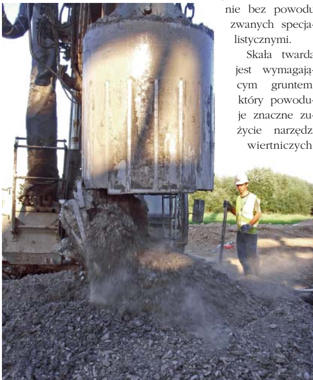
Fot. 8. | Podczyszczanie dna otworu pala wykonywanego w gruncie skalistym za pomocą świdra kubłowego do skały (Most przez rzekę Wisłę w Sandomierzu)
