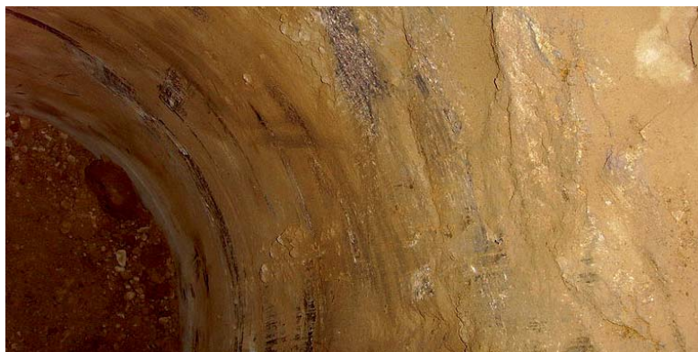
Fot. 12. | Styk koronki wiertniczej z warstwą skały zwierzaląj
