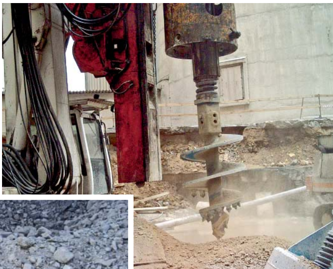
Fot. 4. | Narzędzie wiertnicze – świder do skały podczas pracy
