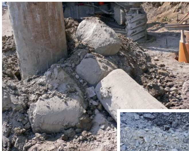
Fot. 3. | Elementy skalne wydobywane przy pomocy świdra koronkowego
